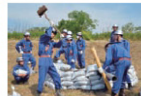
▲水抜き用のパイプを設置
