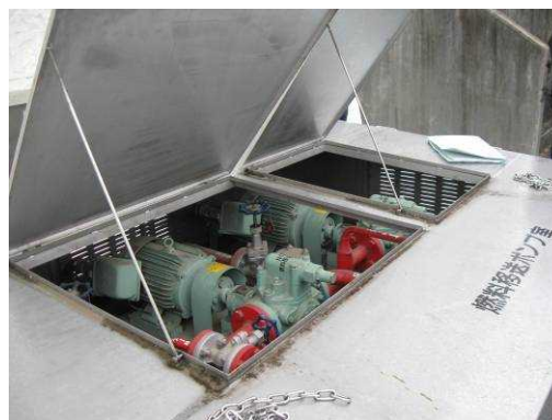
燃料移送ポンプ設置状況
