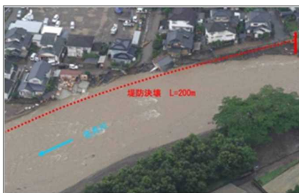
浸食により家屋が流失した状況
