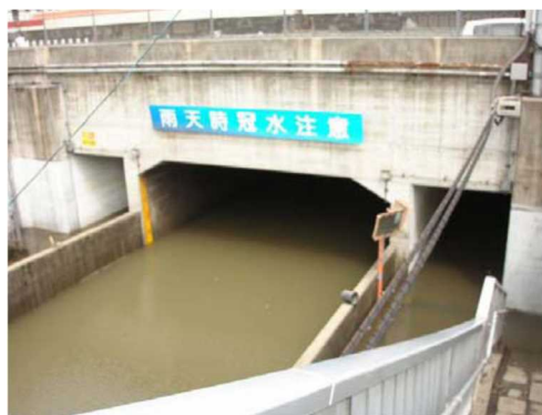
図 3-7 アンダーパス冠水の事例
