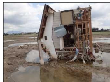
堤防決壊による家屋の倒壊
