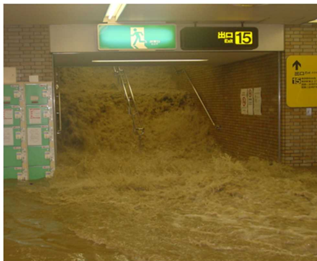
図 3-26 博多駅地下街に流れ込む氾濫水の状況
