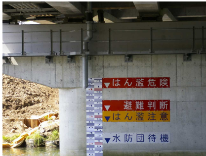
橋脚に水位表示
