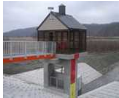
樋管に水位表示
