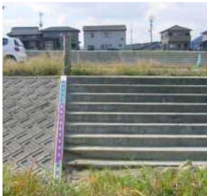
階段に水位表示
