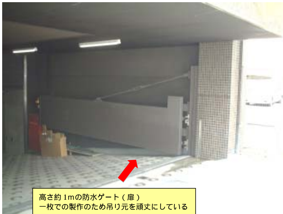
図 4-8 ビル地下駐車場における防水ゲート設置例
