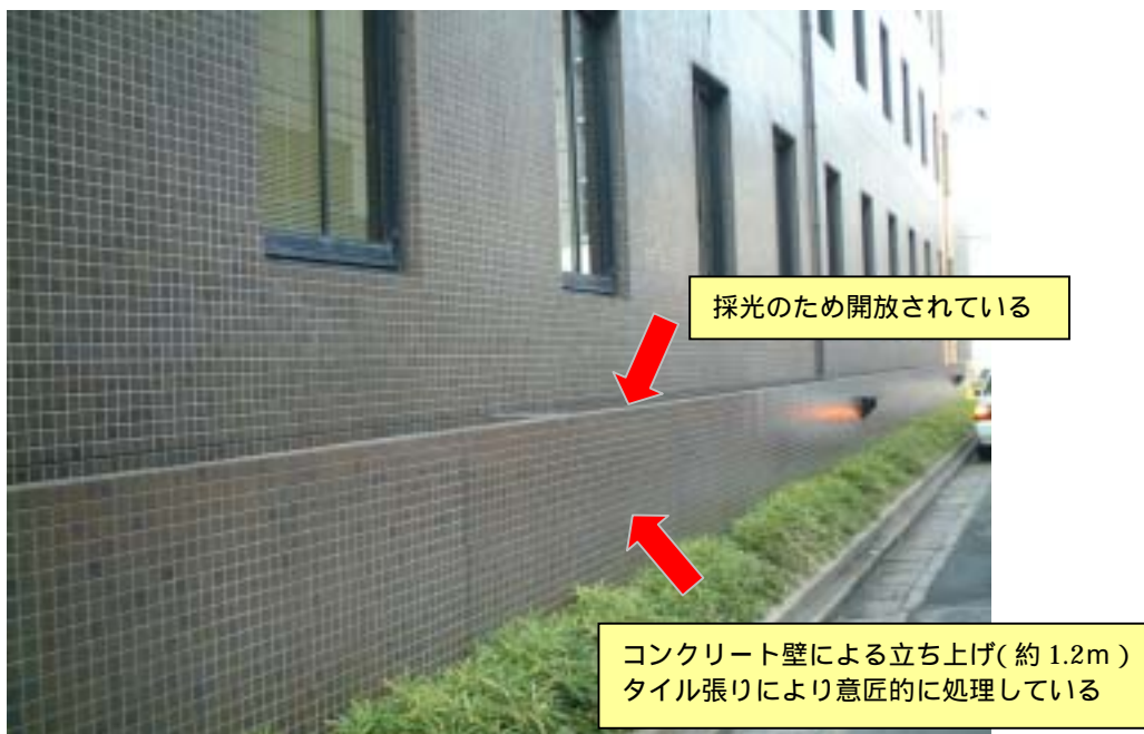
図 4-12 ビル地下の採光部の立ち上げ例
