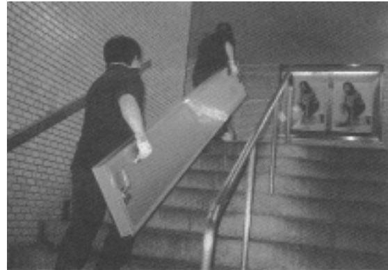
図 5-3 防水板を警備員 2 名で 出入口 1 箇所 5 分～7 分で取り付け
