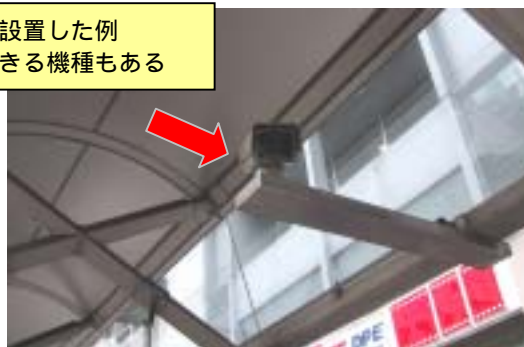
図 4-16 地下出入り口のCCTVによる監視例
