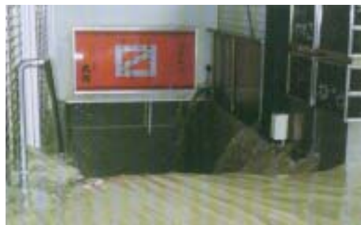
図 1-8 ビルの地下出入口口より勢い良く流れ込む濁流 （出典：1999.6.29～福岡豪雨災害～博多駅周辺の状況～ パンフレット 6.29 博多駅周辺浸水調査委員会）
