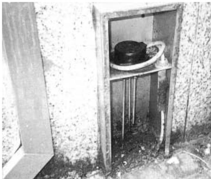
図 4-18 新宿サブナード地下街の浸水センサー設置例（出典：雨水技術資料 VOL.37）
