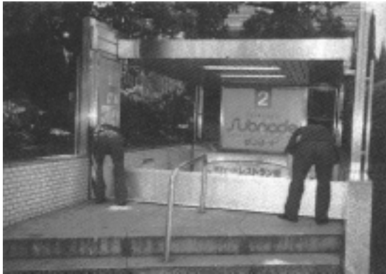
図 5-2 防水板を倉庫より警備員 2 名で移設する
