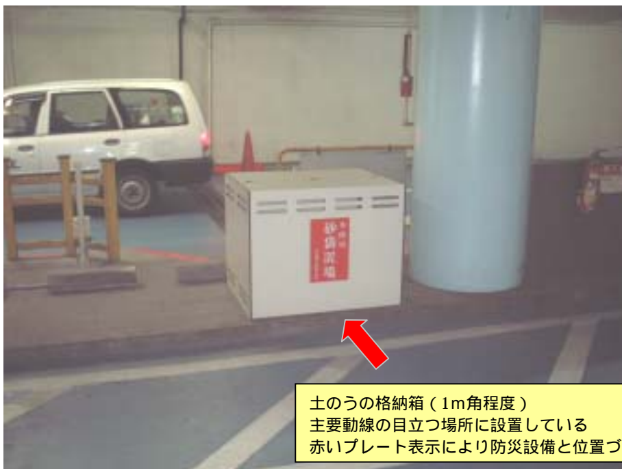
図 4-10 地下駐車場における土のう格納箱設置例
