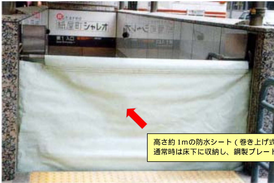
図 4-7 防水シート設置例（出典：広島紙屋町シャレオ地下街建設事業）
